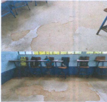
Foto 1: Mejoramiento de piso cerámico (Módulo 1, 2 y 3)
